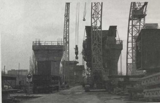
Строительство моста - пройдена половина пути.
